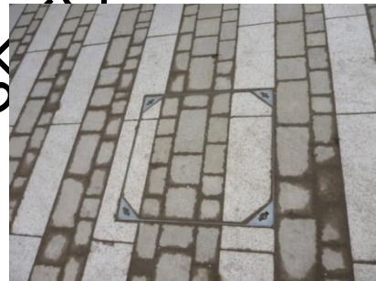
DH pipework access point
